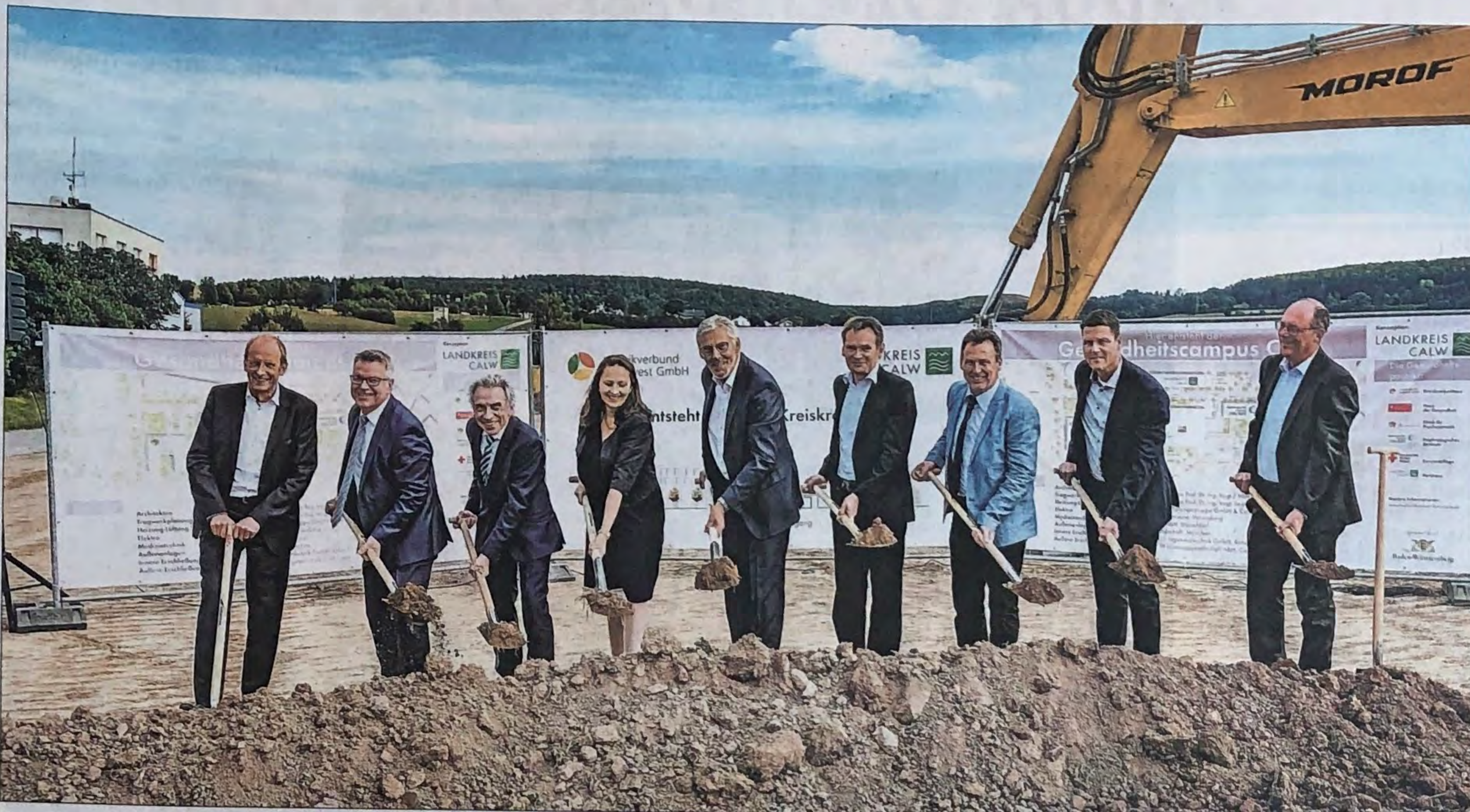
Den Spatenstich für den Gesundheitscampus auf dem Stammheimer Feld feierten die Akteure als weiteren Meilenstein im Medizinkonzept.
