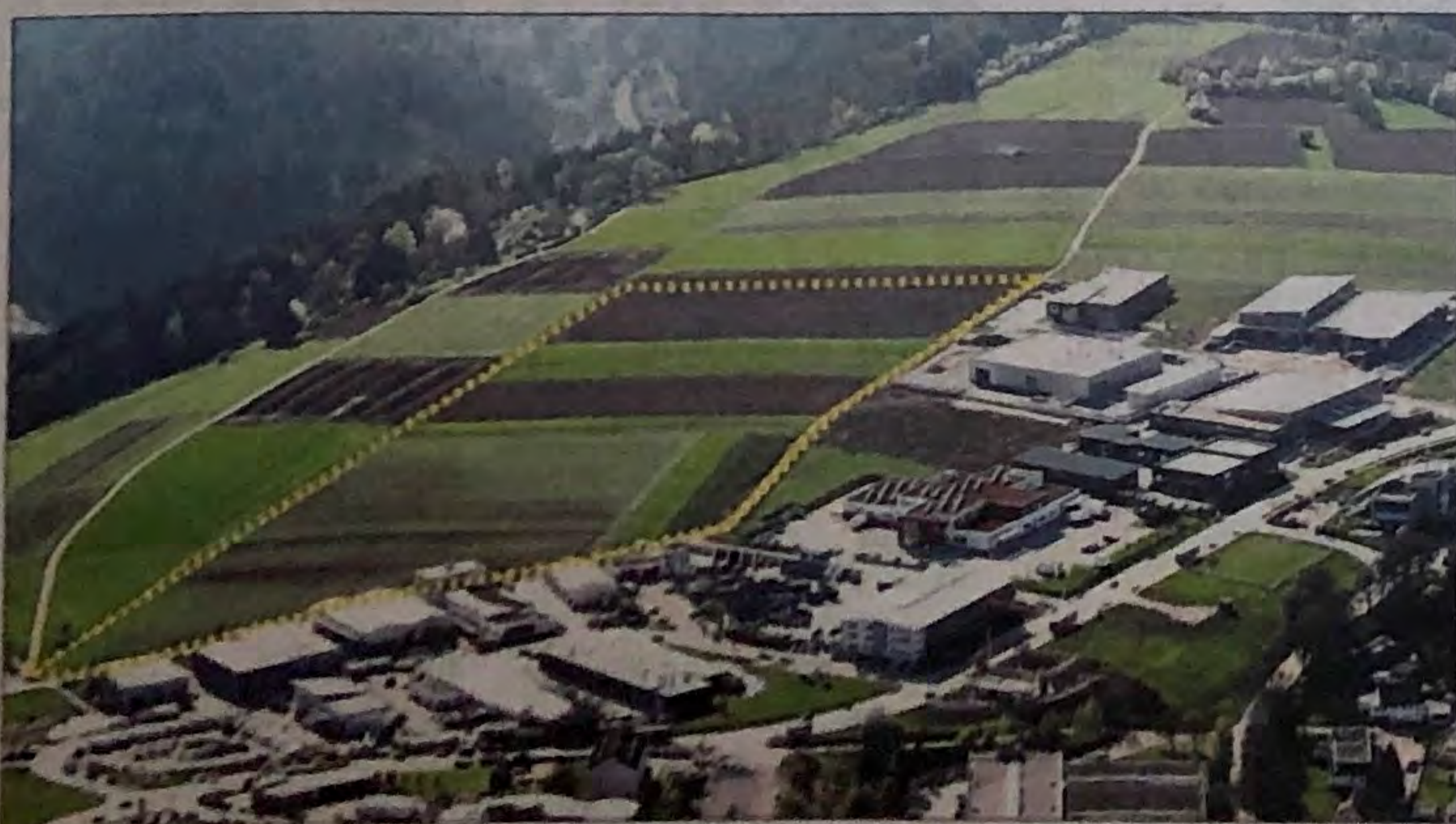
Im gekennzeichneten, rund sieben Hektar großen Areal auf dem Stammheimer Feld III entsteht der Neubau der Kliniken Calw mit angeschlossenem Gesundheitscampus.
